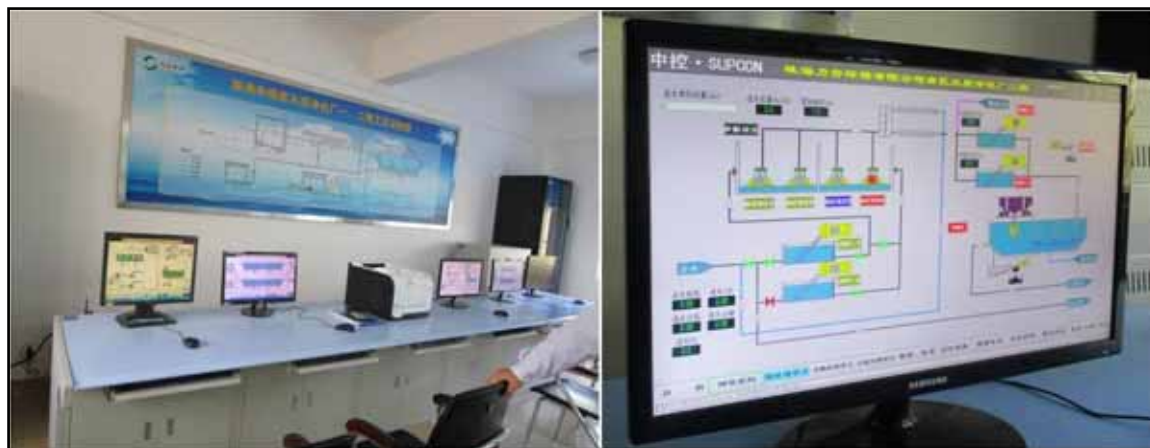
图 3-16 中控室现场情况
